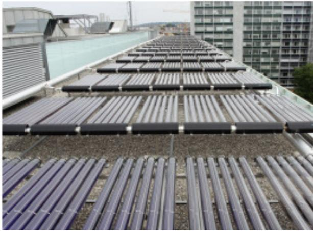
Auf dem Dach des neuen Verwaltungsgebäudes sind 364 Röhrenkollektoren auf einer Fläche von 600 m<sup>2</sup> installiert. Die größte solarthermische Kälteanlage der Schweiz substituiert jährlich umgerechnet etwa 25 000 l Heizöl und trägt zur Reduzierung von 80 t CO<sub>2</sub> bei
