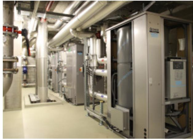
Aus einer solaren Leistung von maximal 300 kW können im Sommer bis zu 210 kW Kälte für die Raumtemperierung erzeugt werden. Die Solarwärme wird bei Pictet in erster Linie für die Trinkwassererwärmung und Raumheizung genutzt
